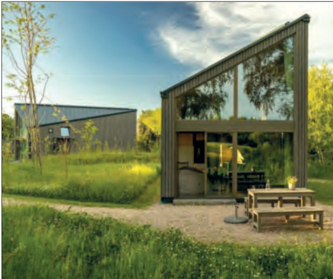
Neugrad-Eifel, einer der insgesamt sieben neuen Betriebe der Angebotsgruppe, befindet sich direkt auf dem Gelände des Internationalen Platz Vogelsang.
