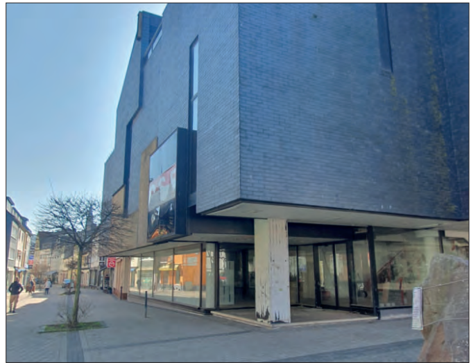
Die Nationalpark-Stadt Schleiden hat dieses Gebäude in der Fußgängerzone von Gemünd angekauft. Hier soll u.a. eine Nachfolge für das Nationalpark-Tor eingerichtet werden, das in der Nähe des Flusses Urft lag und vom Extremhochwasser 2021 zerstört wurde.
